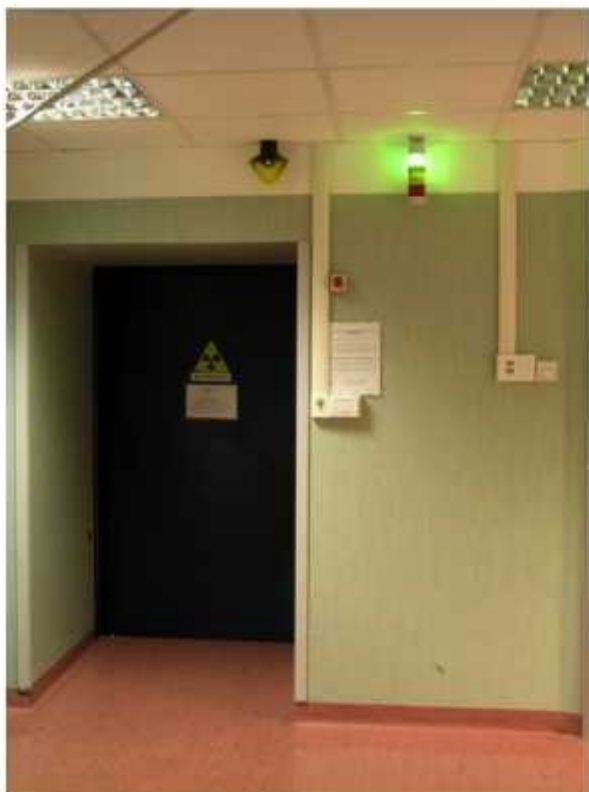
Figura 17. Segnaletica luminosa di avvertimento all'esterno di un bunker di radioterapia.
