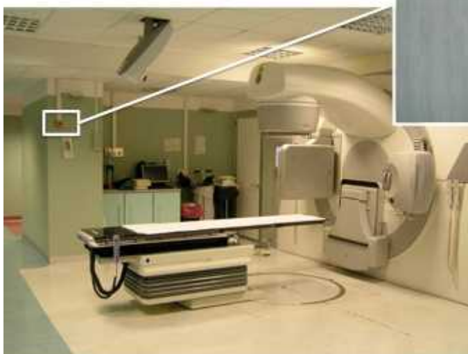
Figura 18. Pulsante di emergenza per l'interruzione dell'emissione raggi.
